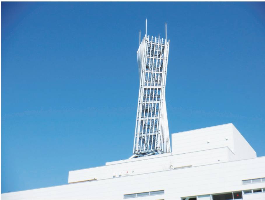
株式会社東日本放送 新社屋屋上 25m鉄塔
